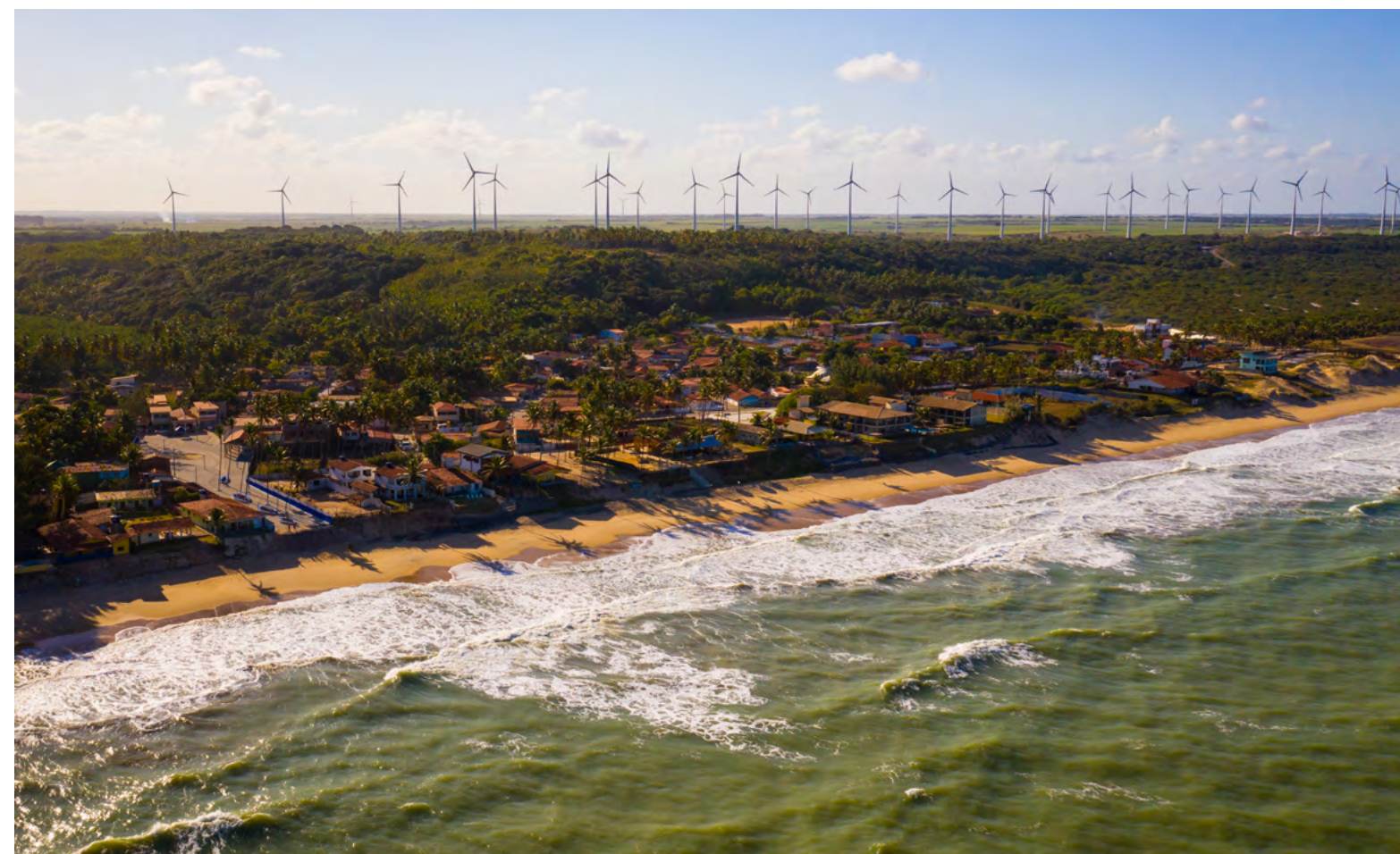
Complexo Eólico Vale do Ventos.
